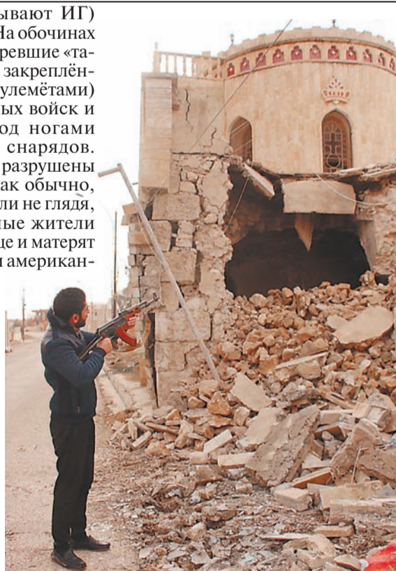
ВВС США бомбили не глядя: две трети зданий разрушены.
