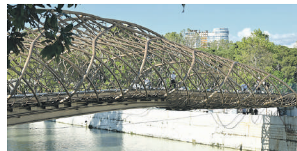
Мост соединил оба берега реки Сочи.
